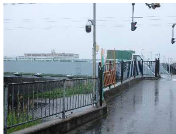
河川改修工事状況監視
