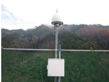
橋梁工事状況監視
