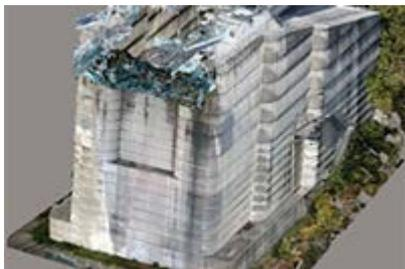
多視点写真解析による3次元モデル
