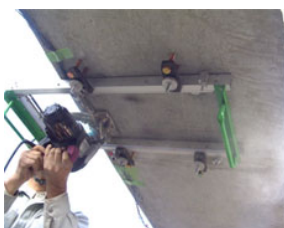
スリット切削状況
