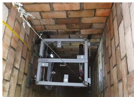
撮影治具を用いた煙突内部の撮影
