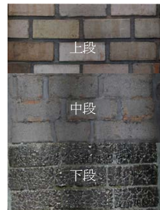
煙突内部の撮影画像
