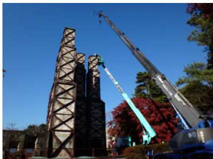
重機を用いた調査状況
