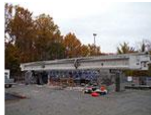
屋外実橋撤去桁
