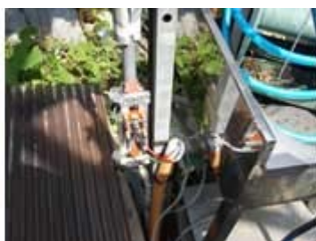
超音波流量計 (既設配管)
