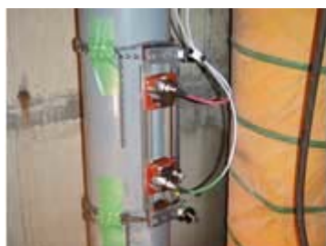
超音波流量計 (既設配管)
