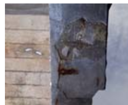
剥離、錆などの損傷を確認
