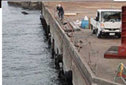
橋梁・港湾構造物の調査点検
