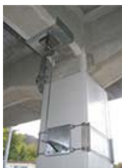
ラーメン高架橋に設置した事例
