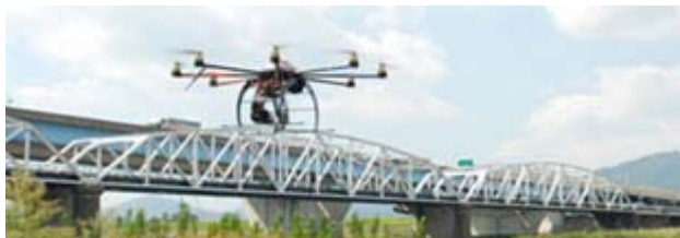
トラス上部へ移動する UAV
