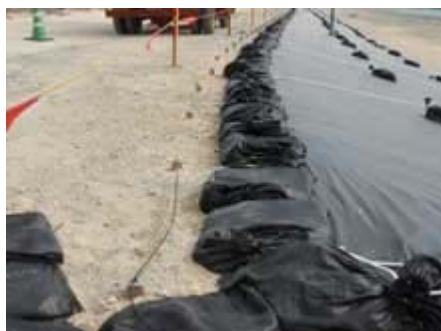
光ファイバセンサ敷設状況(道路護岸の変状監視)
