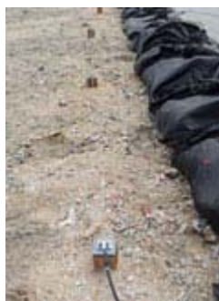
光ファイバセンサ敷設状況(道路護岸の変状監視)
