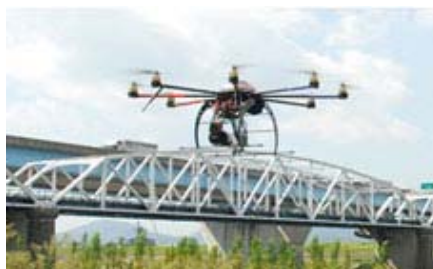
図② トラス上部へ移動する UAV
