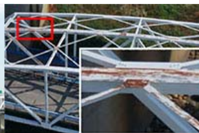
図③ トラス上部からの撮影画像
