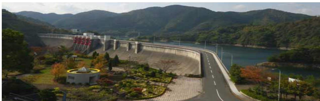
下流側から望む弥栄ダム ※写真提供: 国土交通省中国地方整備局弥栄ダム管理所
