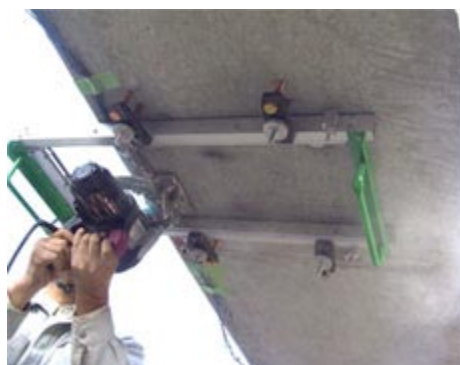
スリット切削状況
