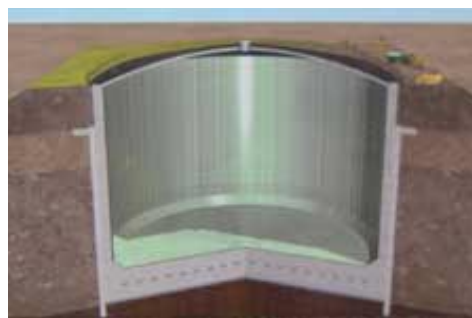
図-1 LNG地下タンクのイメージ
