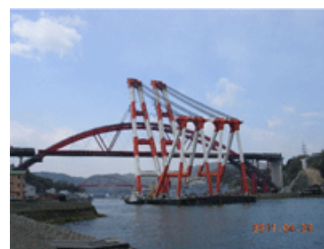
起重機船による中央径間の一括架設
