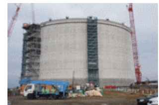
屋根浮上工事状況
