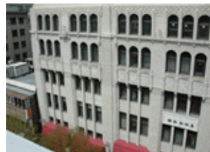
解体前の横浜松坂屋本館
