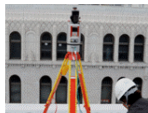
建物全体の3Dレーザ計測
