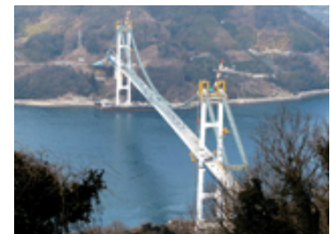
(仮称)豊島大橋
