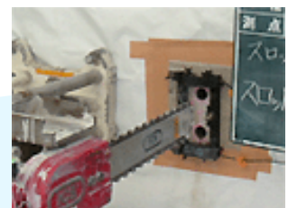
スロット削孔
