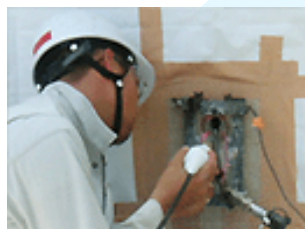
フラットジャッキ挿入
