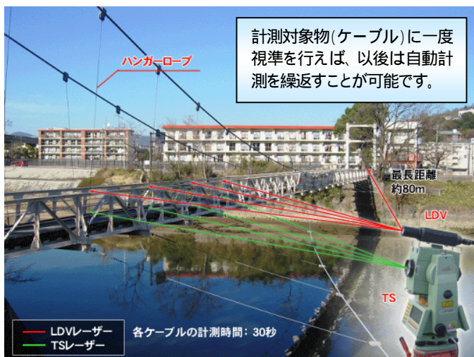
振動計測実験の概要(工兵橋)
