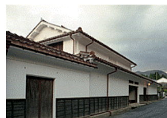
熊谷家住宅外観(修理後)
