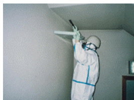
吹付材の採取状況
