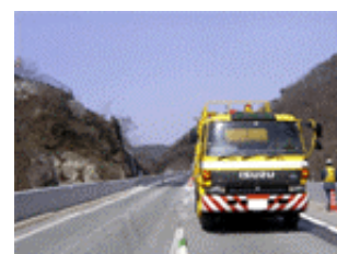
静的荷重試験状況
