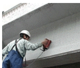
鉄筋探査状況
